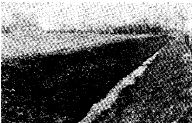
Abb. 19: Fluß-, Kanal- und Küstenbau sowie Landgewinnung (Uferschutz mit Gewebe, BRD)
