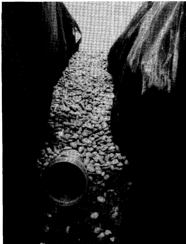
Abb. 10: Entwässerung (Gleisdrainage, Bahnhof Pratteln, CH)
