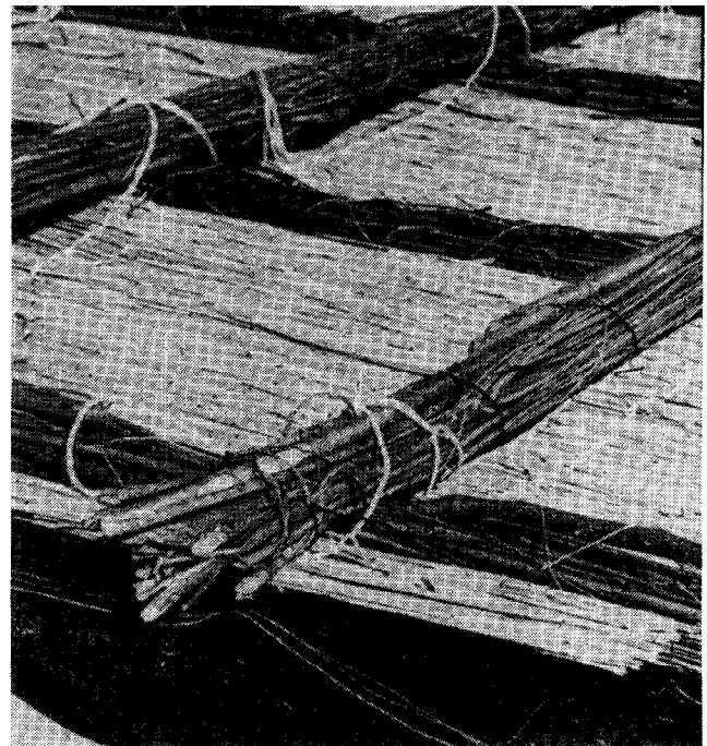
Abb. 20: Fluß-, Kanal- und Küstenbau sowie Landgewinnung (Küstenschutz mit Untergrundbefestigung aus Gewebe und Rohr, NL)
